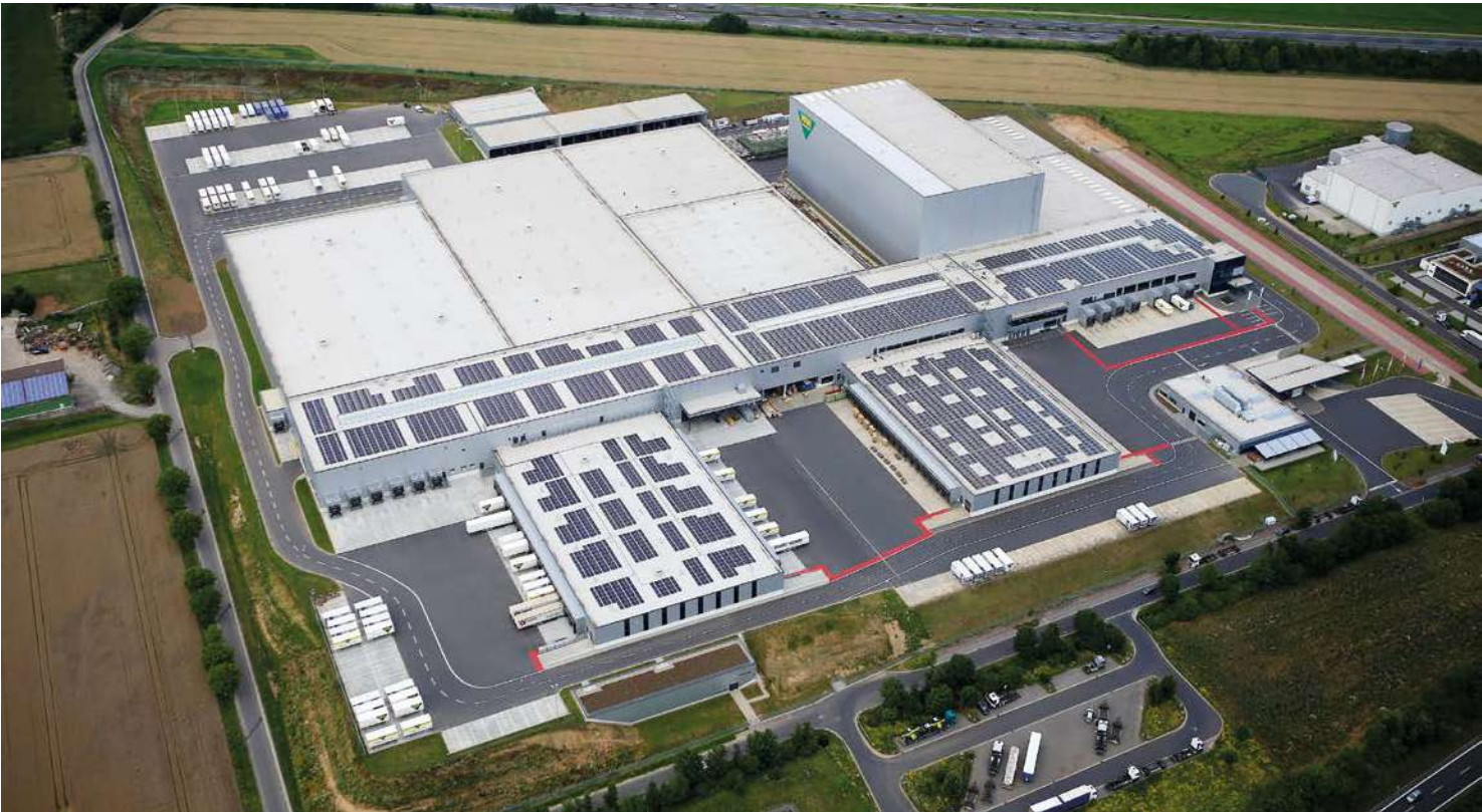
Het centrale magazijn van WM SE beslaat een oppervlakte van 180.000 m 2 .
